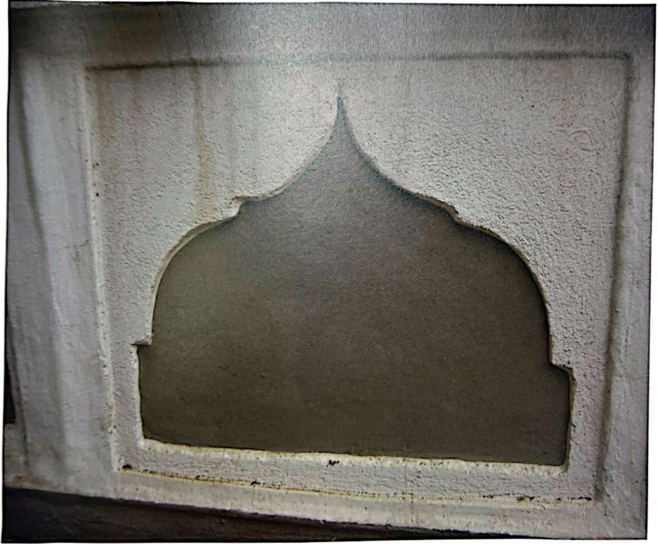
قطعة هندسية على شكل قبة مسجد أو رأس مثذنة تتكرر بجانب بعضها البعض وضعت أسفل الجدار في مسجد السوق
