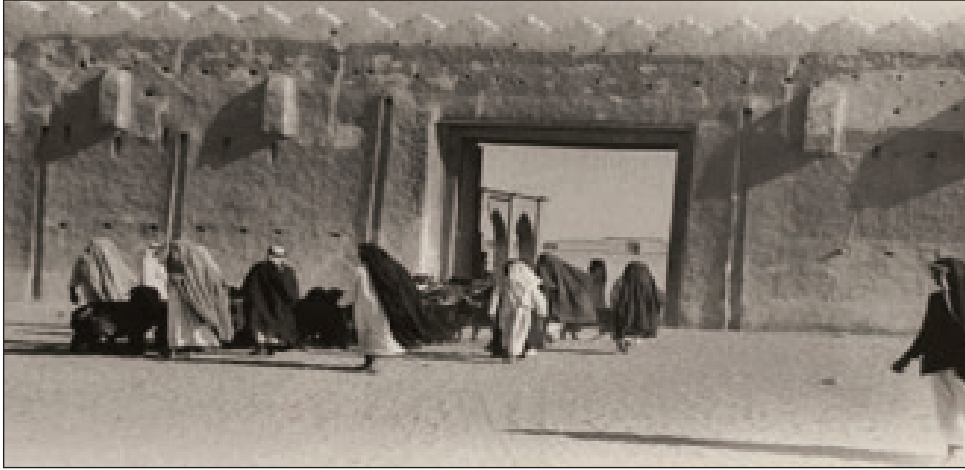
ملحق رقم (٣) صورة توضح شكل بوابة السور. (يعقوب الحجري، الكويت القديمة، ص٨٣).
